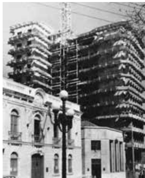
Construção do Edifício Meridional, que aparece no canto direito da foto panorâmica: primeira prédio residencial do centro de Florianópolis
