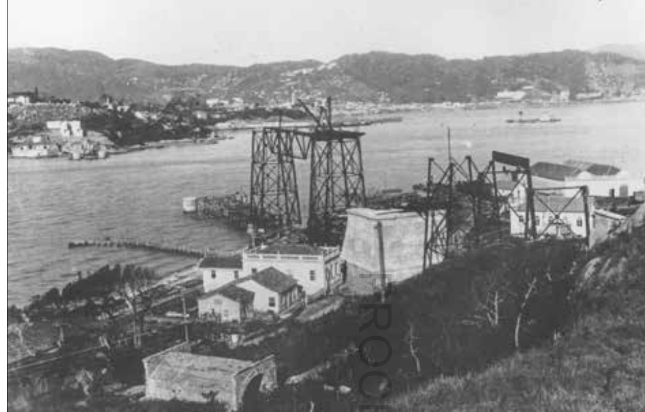
As fundações da ponte Hercílio Luz consumiram 5 mil toneladas de cimento
