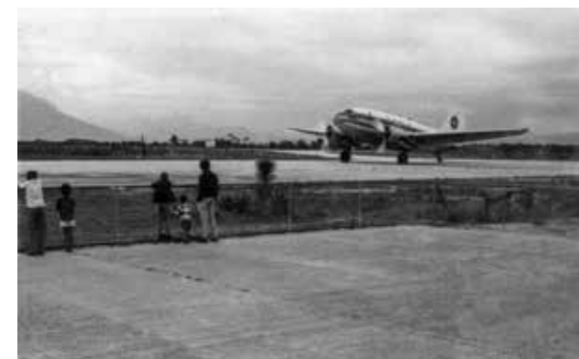
Aeroporto de Florianópolis passava por obras para receber aviões de maior porte
